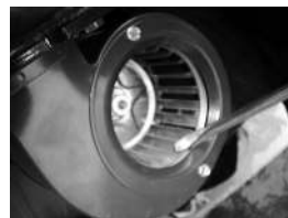
Soufflet d'air de combustion
